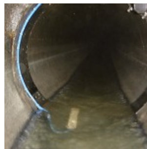
Hydrostatische Messung – zur seitlichen Montage z.B. in sedimentbehalteten Kanälen
