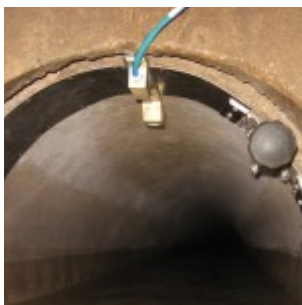
Luft-Ultraschallsensor – zur Erfassung geringer Füllstände z.B. zur Fremdwasserermittlung
