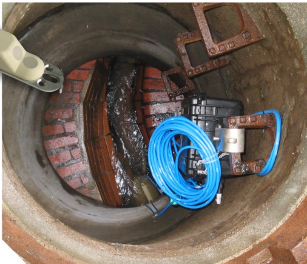
Rohrsensor zur Montage in Rohren und im NIVUS Pipe Profiler
