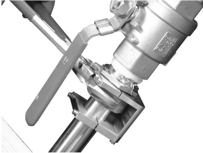
**Fig. 12-37 Desserrer l'écrou-raccord pour le démontage du capteur**
