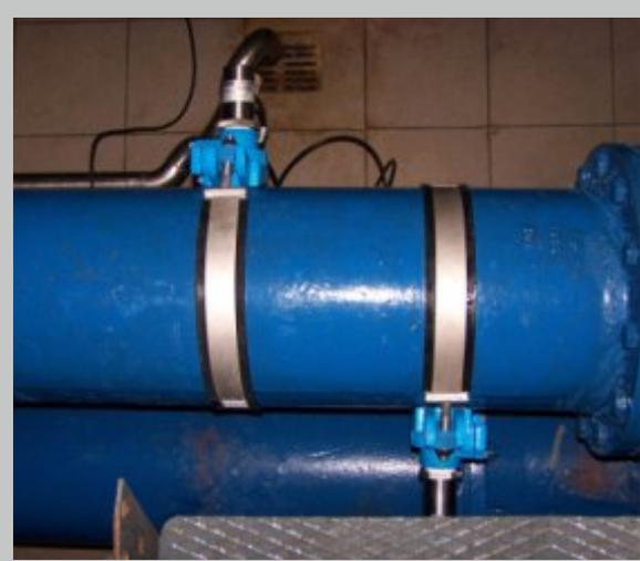
Befüll- und Entleerungsleitung mit installierten Sensoren
