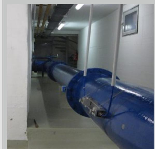
Durchflussmessung mit Clamp-On-Sensoren
