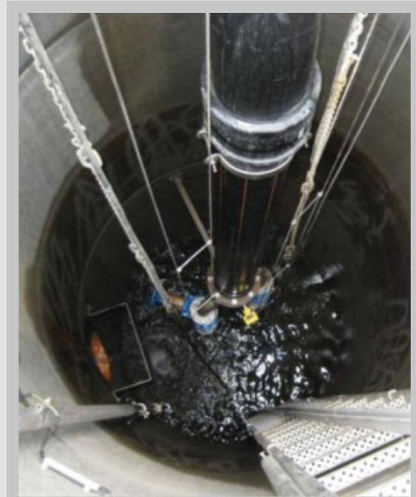
*Pumpenschacht mit zwei Pumpen*
