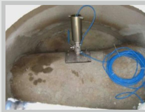
Messschacht mit installierter Ausfahrarmatur
