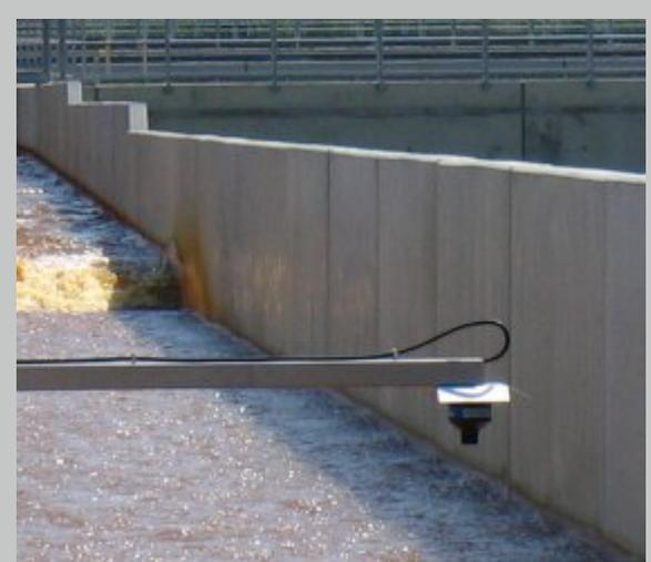
Messstelle mit Füllstandssensor
