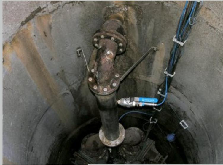
Pumpenschacht mit eingebauter Messung
