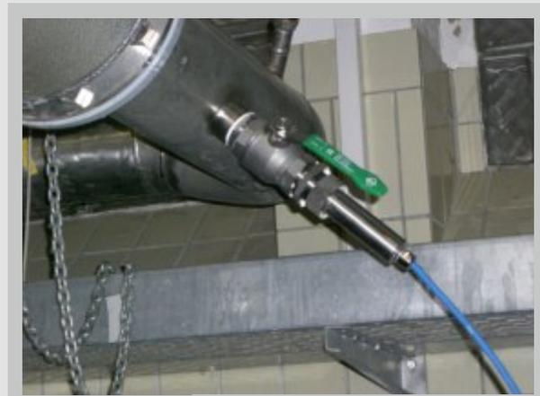
*Messstelle mit eingebautem Sensor*
