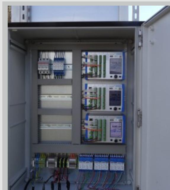
Schaltschrankinstallation der Messumformer
