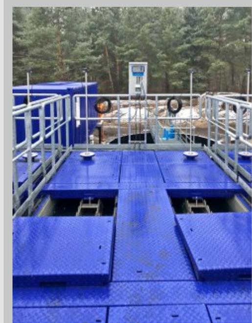
Lamellenfilteranlage mit eingebauten Sensoren
