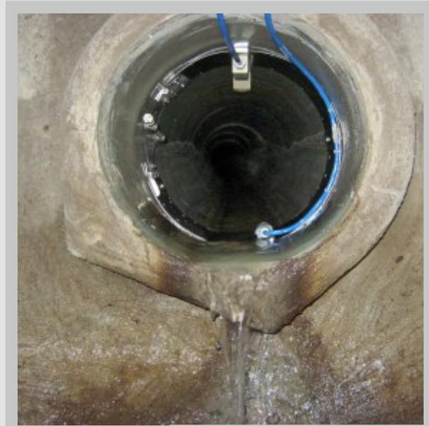
Einbau mit Rohrmontagesystem
