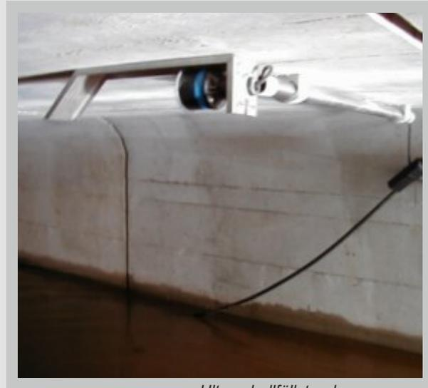
Ultraschallfüllstandsmessung mit Umlenkspiegel
