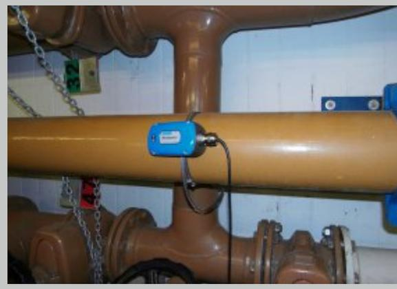
Installiertes Clamp-On Messsystem
