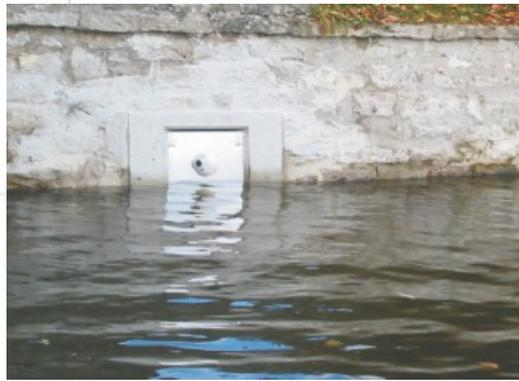
Installation de 8 capteurs hémisphériques disposés sur 4 cordes croisées et mesurant sur 2 niveaux. Dès lors que le niveau d'eau atteint une certaine cote, les cordes des niveaux supérieurs, dénoyées en temps normal, se connectent. Les capteurs ont été vissés sur une plaque en acier inox, accessoire à se procurer chez Nivus. Le génie civil a été réalisé au préalable.
