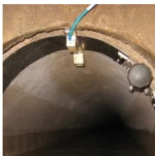
Capteur ultrason aérien – pour l'acquisition de faibles débits tels que p. ex. détection d'eaux parasites
