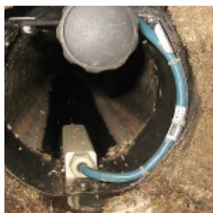
Ultrason immergé et mesure hydrostatique pour p. ex. l'enregistrement d'événements pluvieux
