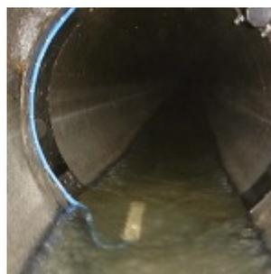
Mesure hydrostatique – pour un montage décentré p. ex. dans des conduites à risque de sédimentation
