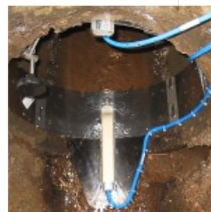
Ultrason aérien, ultrason immergé et mesure hydrostatique – acquisition de l'ensemble de la plage d'écoulement p. ex. pour la détermination de la capacité du réseau d'assainissement
